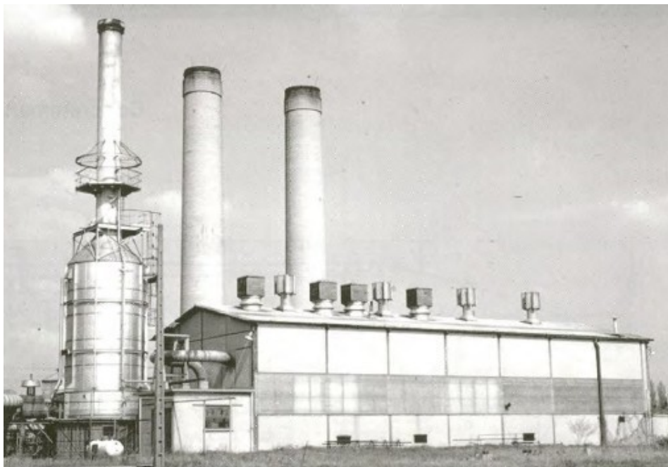
Fig. 7 La chaufferie 2 (chaudières du Montcalm )
