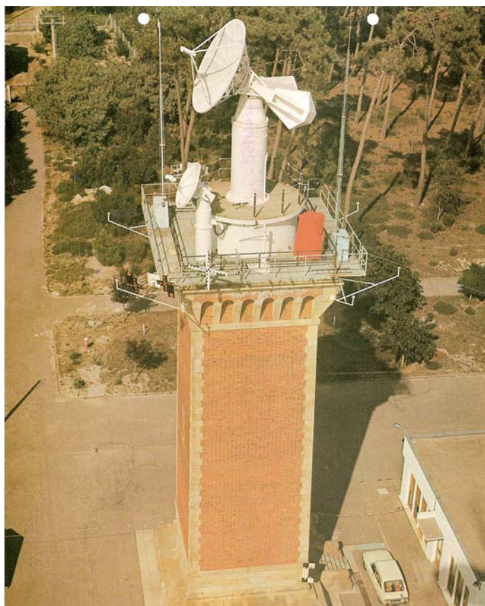
Fig. 16 Le phare désaffecté d'Houert à Hourtin A son sommet, des antennes Antarès. A l'origine, il était coiffé par une antenne Télémaque.
