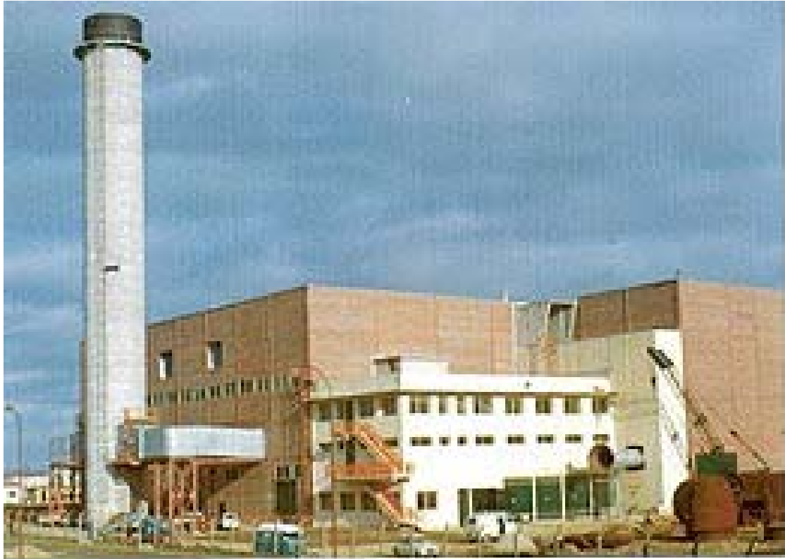
(a) Le Bâtiment C, une imposante installation
