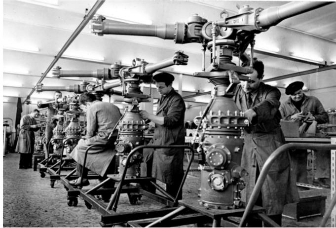
Figure 32 - La Courneuve. Chaîne BTP et moyeu Alouette II
