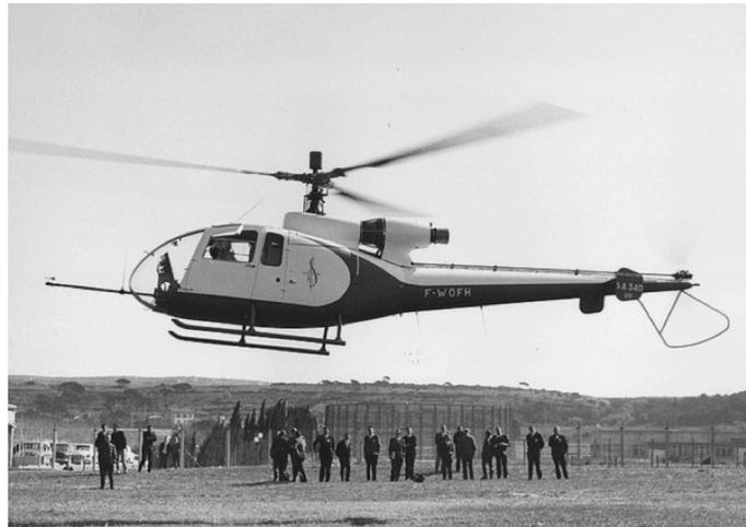
Figure 80 - SA 340-001 avec le rotor anticouple de l'Alouette
