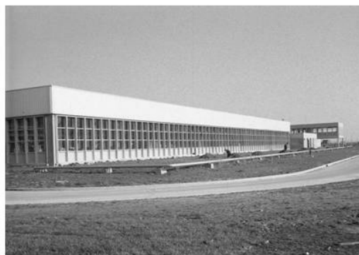
Le bâtiment des ateliers
