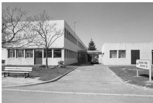
L'entrée du centre de Formation
